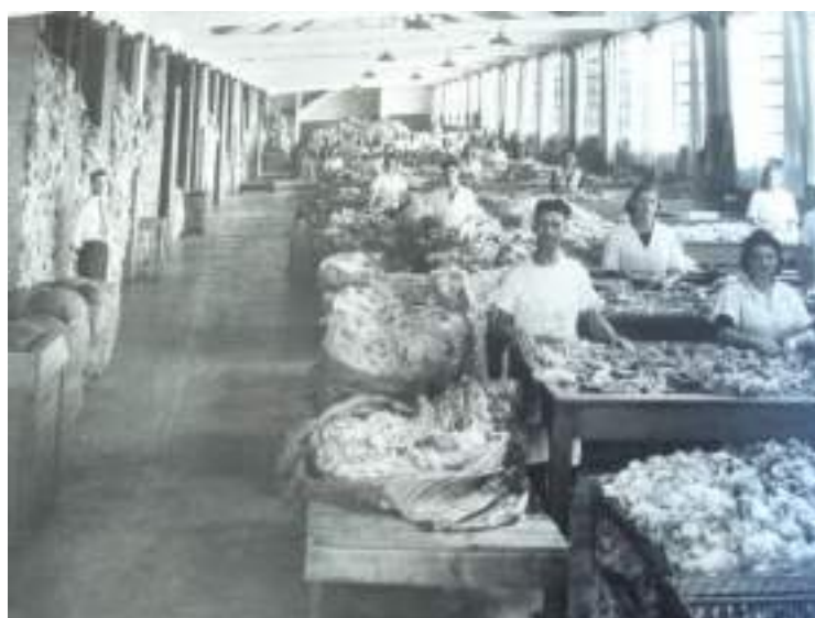
Figura 6 - Entrada da matéria-prima no processo de fiação Fonte: Teixeira (2007, p. 82).
